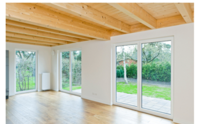
Holzbalkendecke und Massivbauwände
