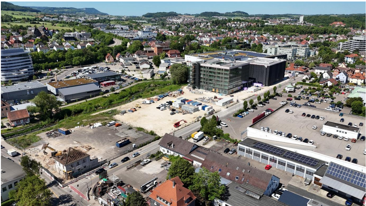
Gesamtperspektive mit Blick auf das ehemalige Union-Gelände: vorne links noch letzte Abbrucharbeiten beim angrenzenden „Mühlich-Areal“, daran anschließend die Freifläche für die Errichtung der Park- und Mobilitätsstation (22.05.2026)
