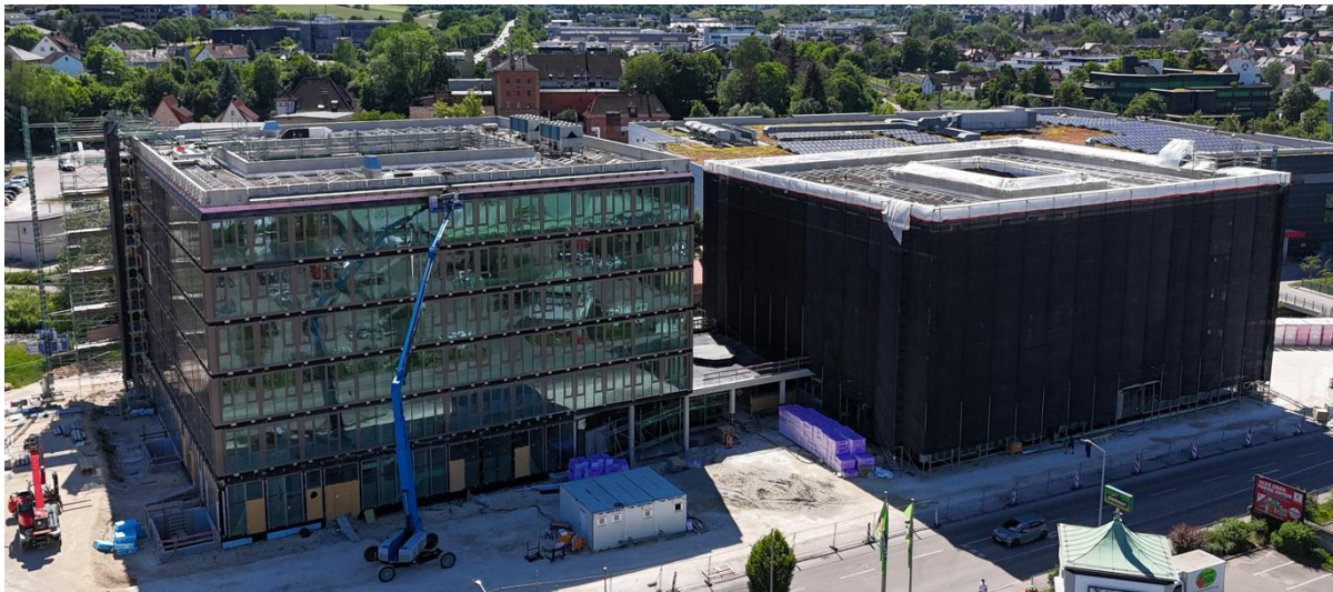
Montage der Konsolen an Gebäude 2 für den Sonnenschutz und die Großlamellen (28.05.2026)
