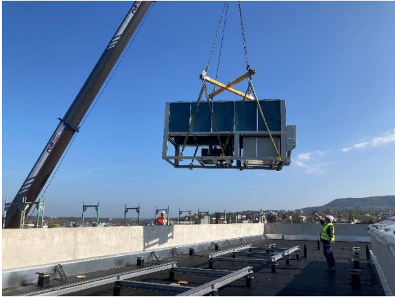
Anlieferung und Installation der beiden Luftwärmepumpen (16.04.2026)
