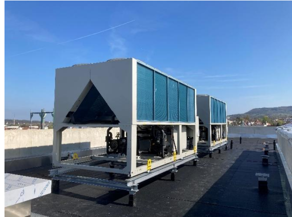
Anlieferung und Installation der beiden Luftwärmepumpen (16.04.2026)
