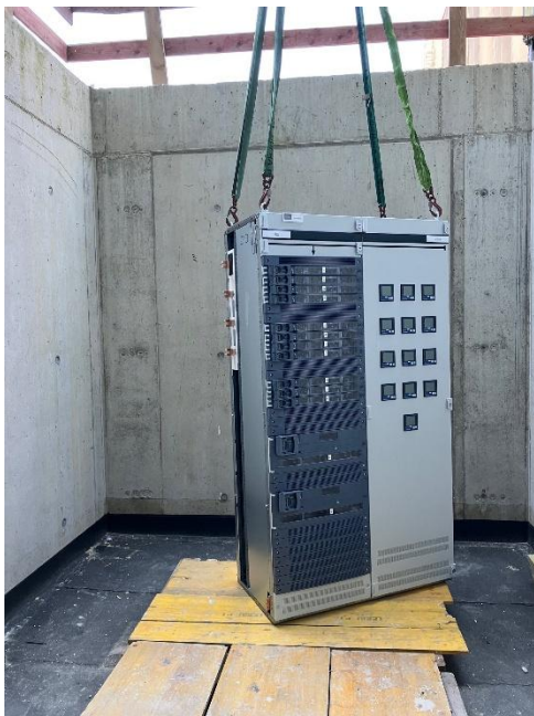
Einbau Niederspannungshauptverteilung
