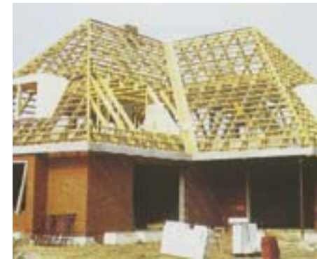
Dachstühle aus Holz sind immer noch die wirtschaftlichste Lösung.
