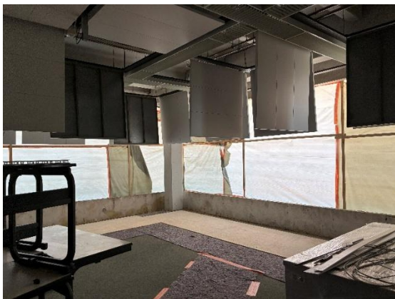
Nach Abbruch der Fassade im 1. Abschnitt
