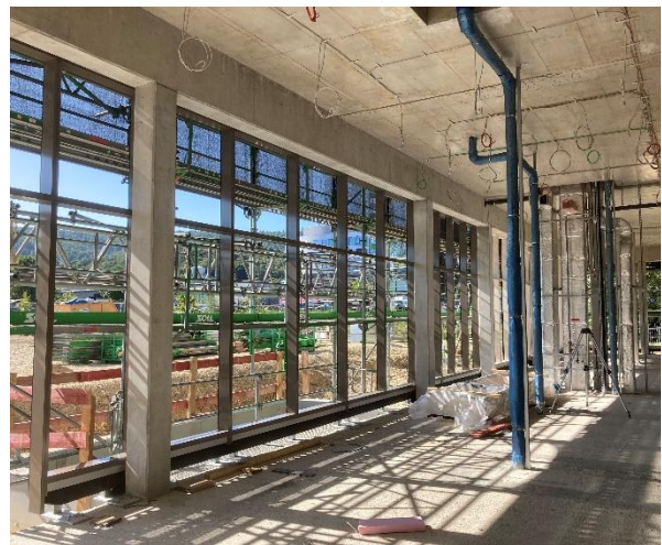
Innenansicht Gebäude 2 (August 2025)
