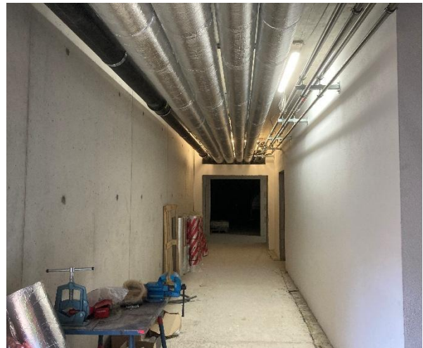
Verlegung der Grundleitungen im UG
