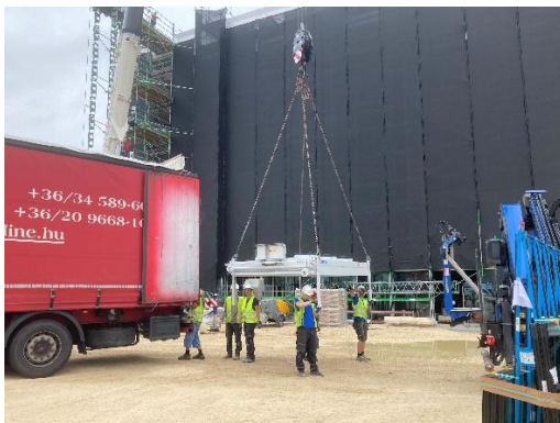
Anlieferung des Rückkühlers für die Lüftungsanlage
