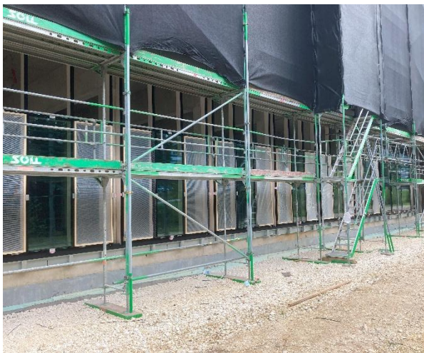
Einbau erster Fassadenelemente im EG von Gebäude 2 (August 2025)
