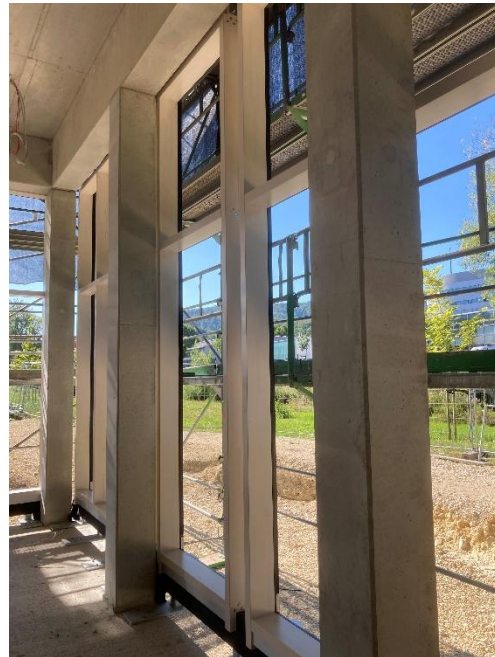
Innenansicht Erdgeschoss: Einbau der Fassadenelemente
