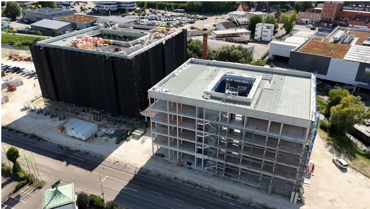
Luftaufnahme August 2025: Fassadengerüst mit schwarzem Schutznetz am Gebäude 2 zur Montage der Fassadenelemente sowie Errichtung Fassadengerüst am Gebäude 1
