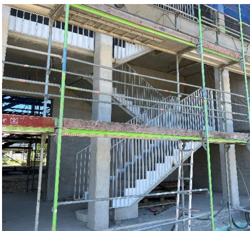
Erste Treppengeländer im Gebäude 1
