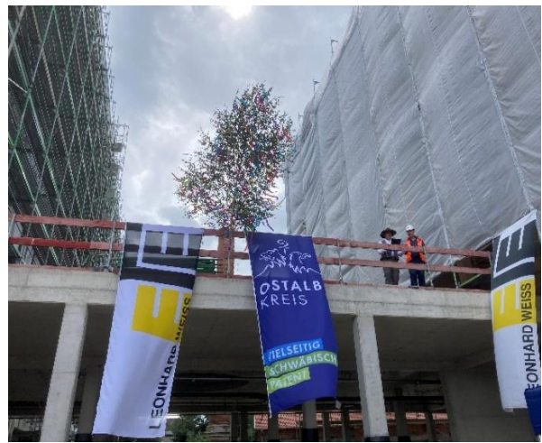
Richtspruch durch den Rohbauer Fa. Leonhard Weiss (Satteldorf)
