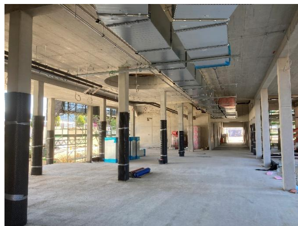
Montage erster Lüftungskanäle im EG (Verbindungsbau Gebäude 1 und 2)
