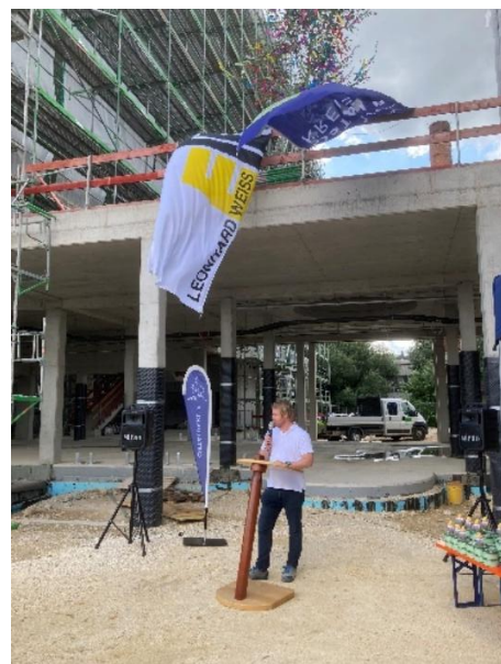
Grußwort für die örtliche Bauleitung Ernst 2 -Architekten des Standortbüros Aalen durch Herrn Tobias Landwehr
