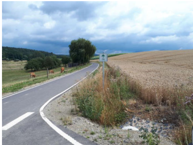
Abbildung 21: Beispiel eines Wirtschaftsweges mit Randmarkierung (Quelle: Eigene Aufnahme)
