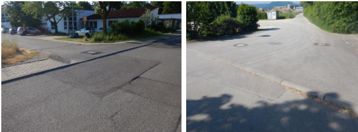
Abbildung 18: Beispiele nicht abgesenkter Bordsteine im Ostalbkreis (Quelle: Eigene Aufnahmen)
