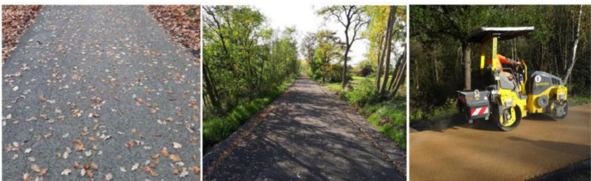
Abbildung 14: Asphaltähnliche Deckschichten aus Gemisch von Basaltstein und Spezialsand / heller Split-Mastix-Asphalt (Quelle: Eigene Aufnahmen)
