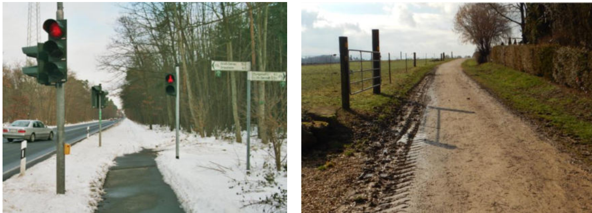
Abbildung 16: Ende eines geräumten Radweges an einer Gemarkungsgrenze / verschmutzter Wirtschaftsweg (Quelle: Eigene Aufnahmen)
