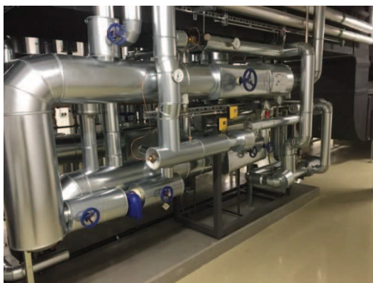
Abbildung 7 Frischwasserstation BT G
