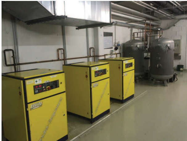
Abbildung 13 Kompressoranlage
