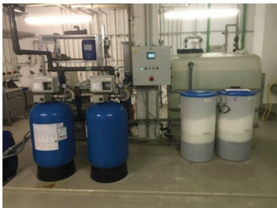
Abbildung 14 Neue Doppelfilterenthärtungsanlage
