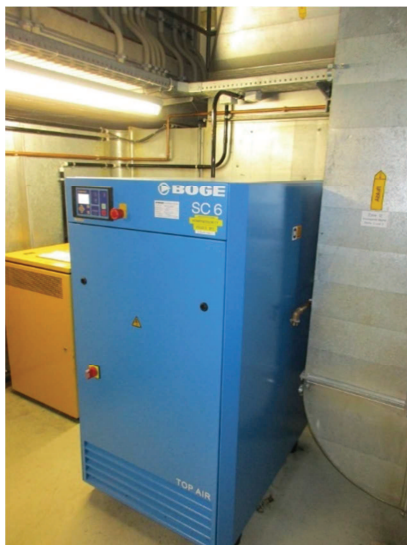
Bild 4 Kompressoren medizinische Druckluft
