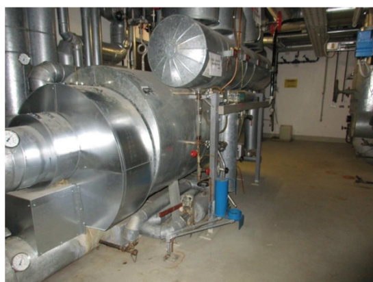
Bild 1 Reindampferzeuger Sterilisation Scheer & Cie.; Baujahr 1986; 1.503 l, 1.143 kW
