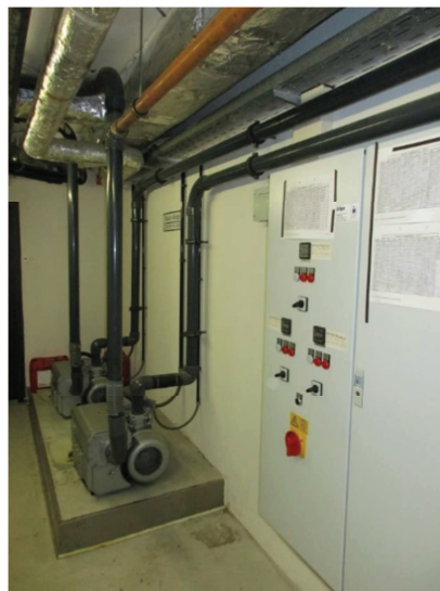
Bild 5 Vakuumanlage
