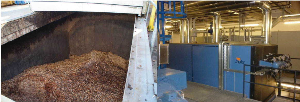
Bild 2 Holz hackschnitzel-Silo
