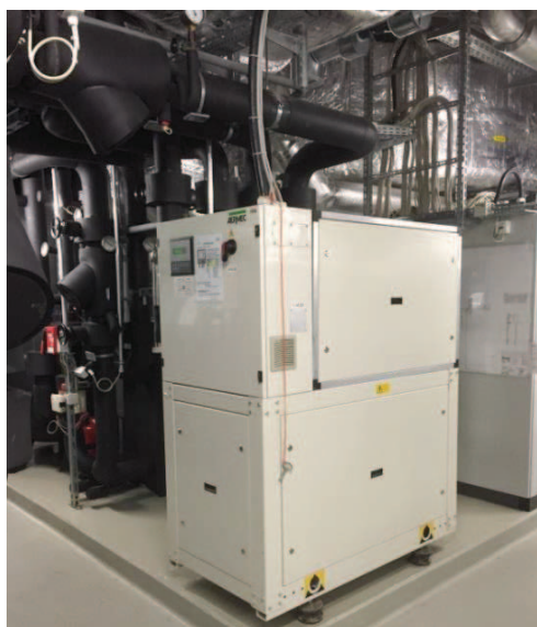
Abbildung 11 Kompressionskältemaschine
