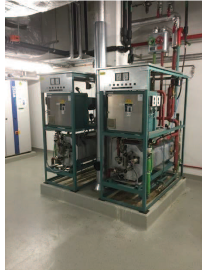
Abbildung 10 Reindampferzeuger
