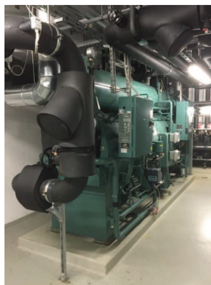
Abbildung 12 Absorptionskältemaschine
