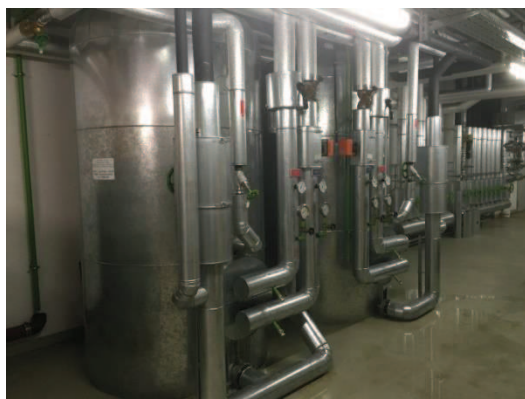
Abbildung 8 Konventioneller Warmwasserbereiter
