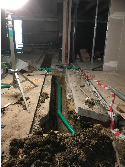
Neue Grundleitung Friseurwerkstatt
