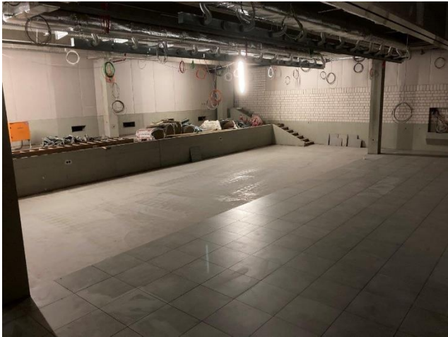
Neuer Fliesenbelag Aula
