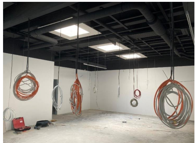
Malerarbeiten Wände und Decke
