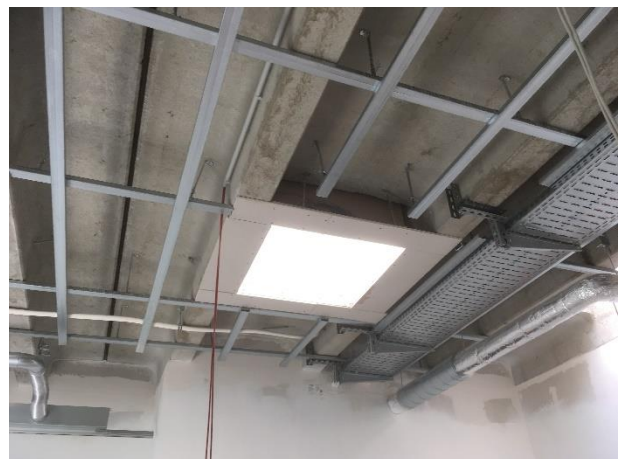
Unterkonstruktion abgehängte Decke / Deckensegel
