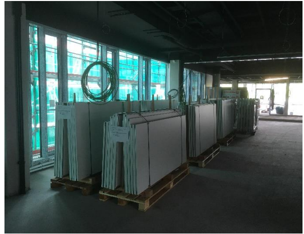
Vorbereitung Montage Systemtrennwände
