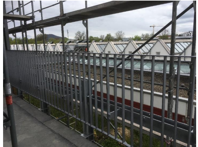
Geländer Balkon West
