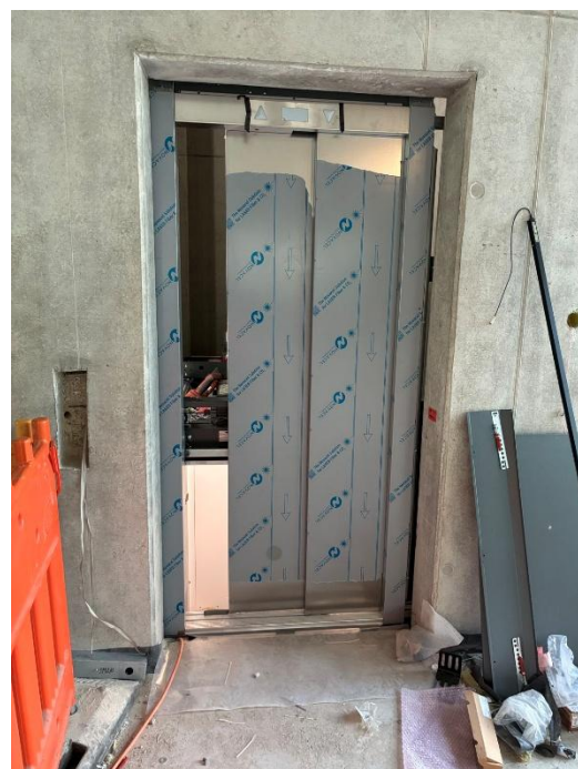
Die Führungsschienen in den Aufzugsschächten wurden montiert und die Aufzugskabinen und Eingangsportale bereits installiert. Nach der Demontage der außenliegenden Gerüstaufzüge werden die Personenaufzüge unter entsprechenden Schutzmaßnahmen für den Materialtransport im Gebäude verwendet.
