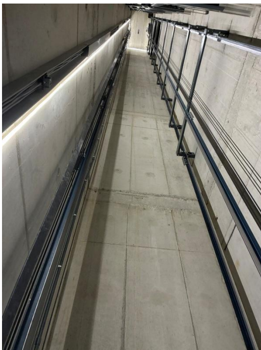
Die Führungsschienen in den Aufzugsschächten wurden montiert und die Aufzugskabinen und Eingangsportale bereits installiert. Nach der Demontage der außenliegenden Gerüstaufzüge werden die Personenaufzüge unter entsprechenden Schutzmaßnahmen für den Materialtransport im Gebäude verwendet.
