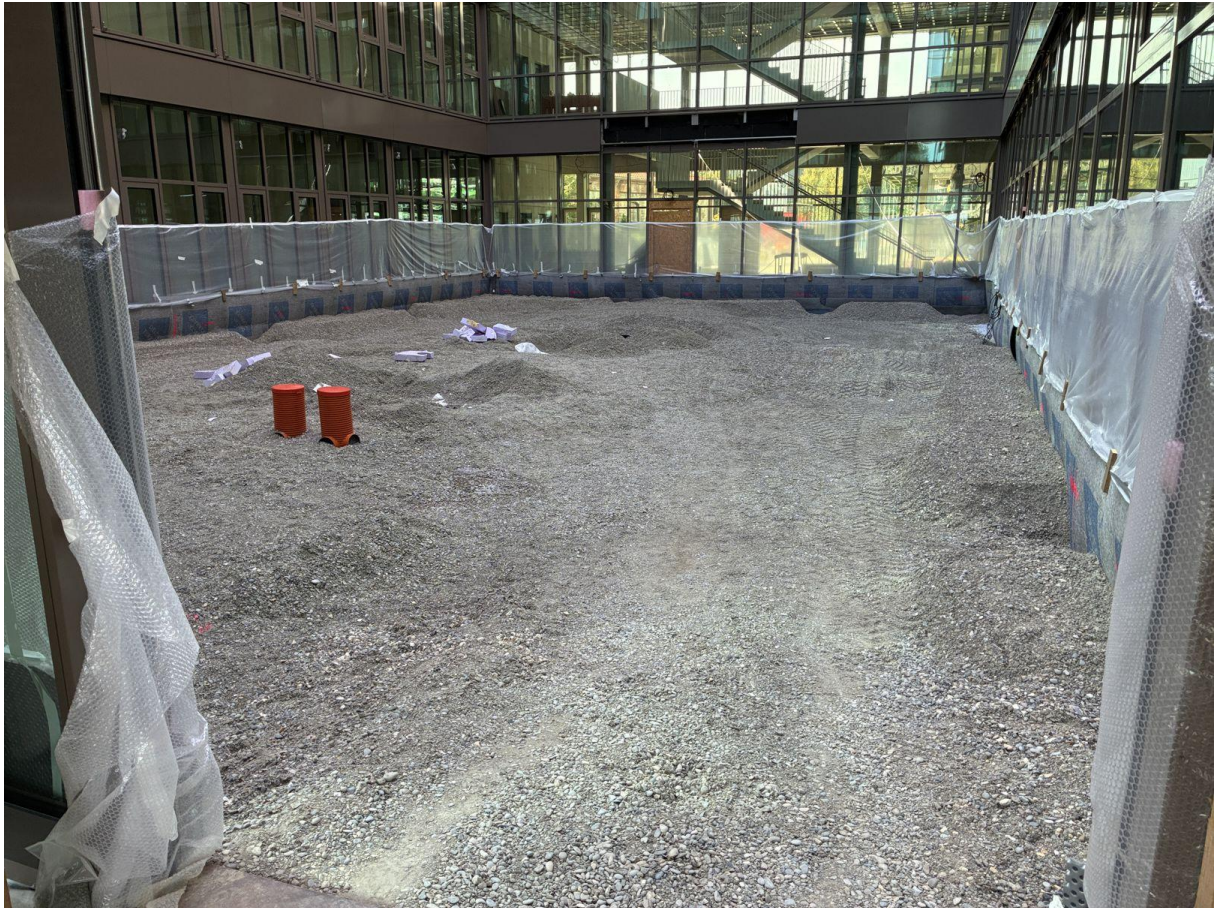
Bei Gebäude 2 haben die Arbeiten zur Gestaltung der Innenhöfe begonnen.
