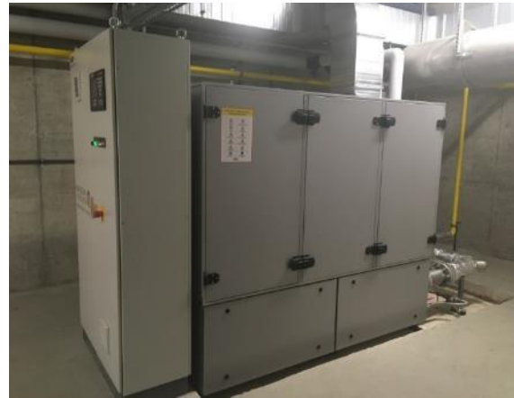
Abb. 19: Eingebautes BHKW
