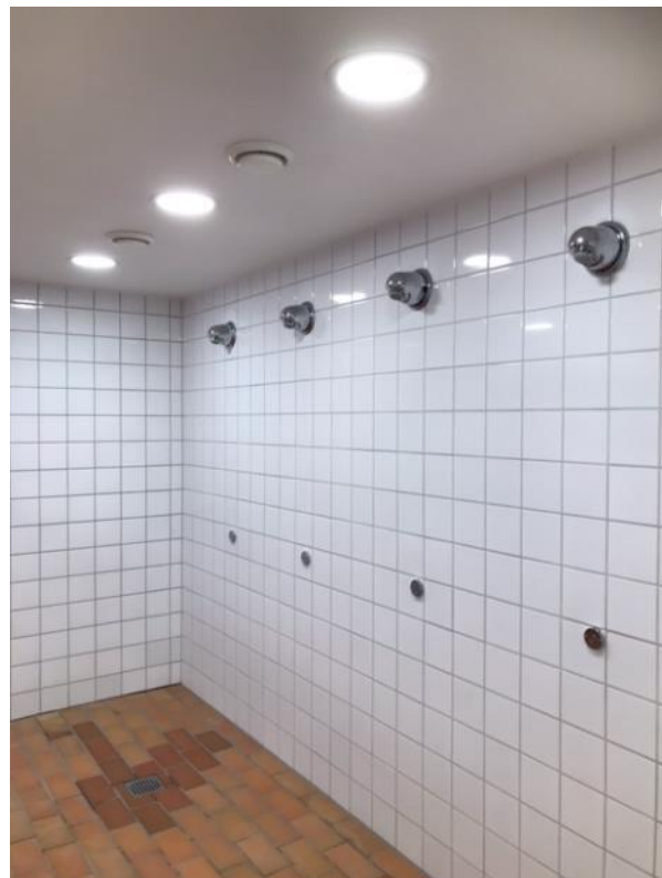
Abb. 43: Duschbereich nach Sanierung
