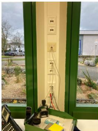
Abb. 48: Fertiggestellte strukturierte Verkabelung
