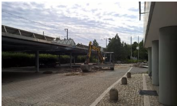
Abb. 6: Beginn Abbrucharbeiten (BA 3)
