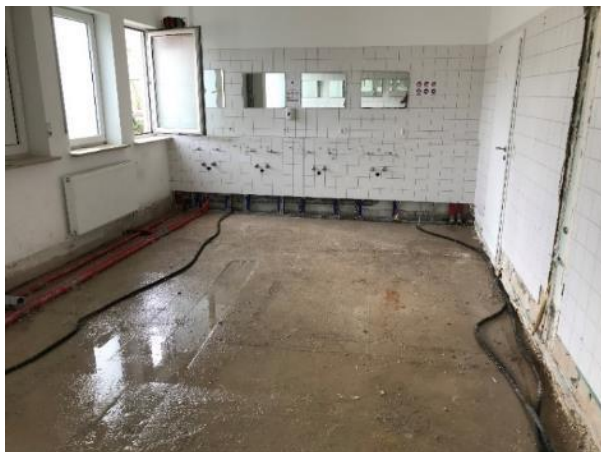
Abb. 49: Abbruch des Fußbodens bis zur Rohdecke
