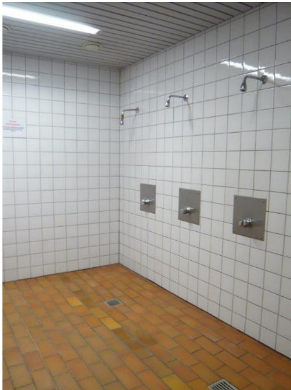
Abb. 42: Duschbereich vor Sanierung
