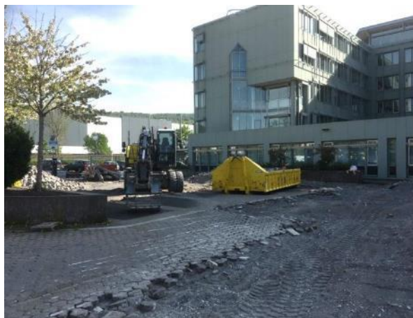
Abb. 4: Beginn Abbrucharbeiten (BA 2)
