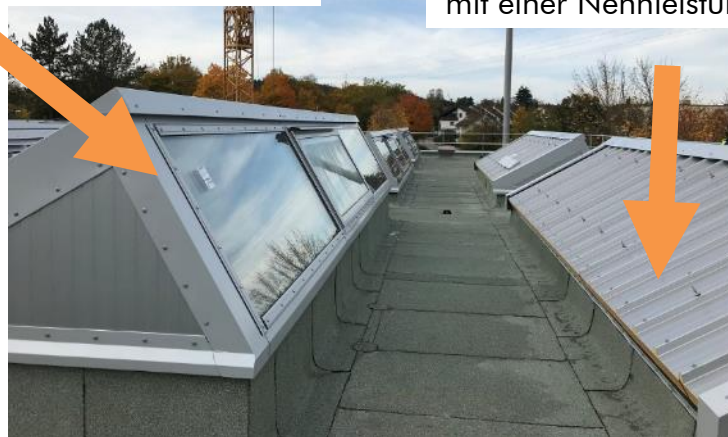
Abb. 27: Erneuerte Dachfläche der Werkstätten
