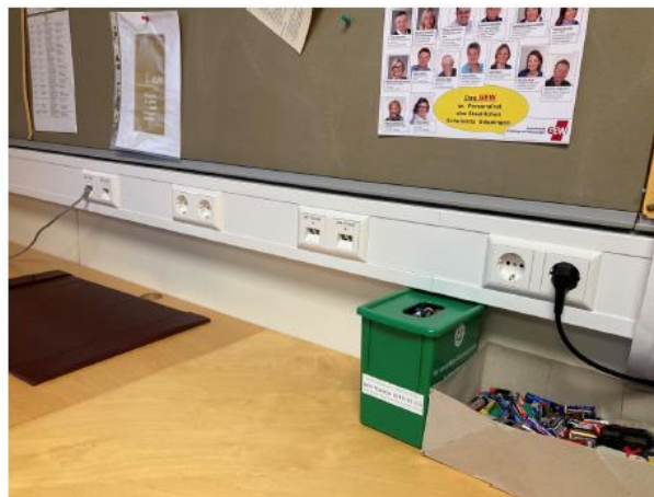
Abb. 48: Fertiggestellte strukturierte Verkabelung
