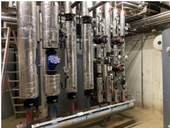
Abb. 46: Erneuerte Heizungsverteilung
