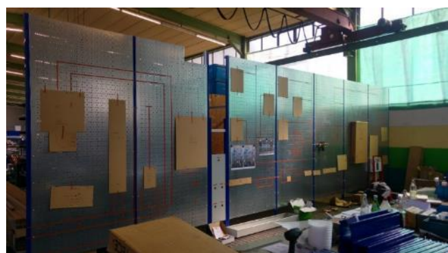
Abb. 29: Vorbereitung Projektwand Haus- und Trinkwasserinstallation
