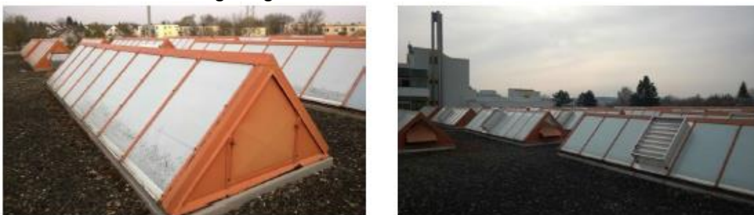
Abb. 24: Alte Oberlichtbänder („Sägezahndach“)
