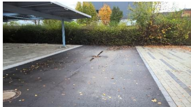
Abb.7: Fertiggestellte Belagsarbeiten (BA 3)
