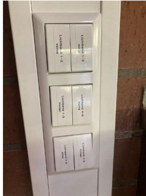
Abb. 62: Neue Lichtschalter Installation
