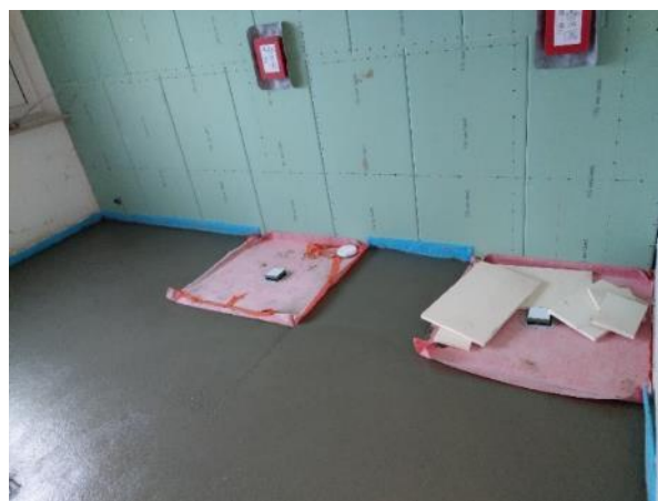
Abb. 50: Einbringung Schnellestrich in den Duschen
