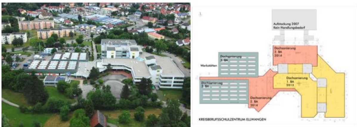
Abb. 23: Dachflächen KBSZ Ellwangen inkl. Einteilung der Bauabschnitte.
