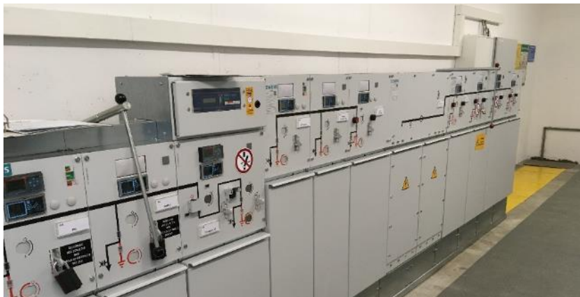
Abb.35: Erneuerte Mittelspannungsschaltanlage
