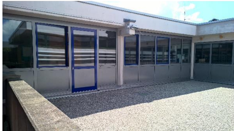
Abb. 45: Neue Fassade, davor Splittbett
