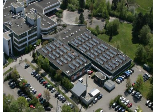
Abb. 26: Werkstattdächer vor Sanierung
