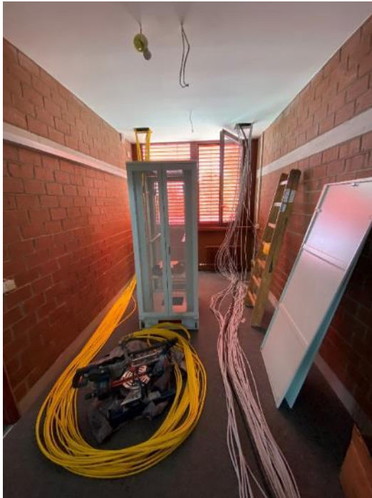
Abb. 61: Neue EDV-Installation
