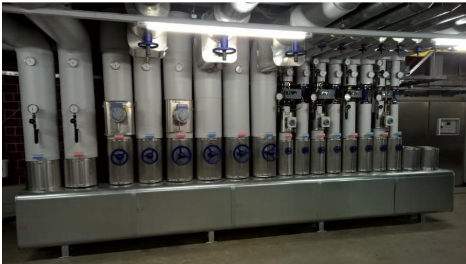
Abb. 20: Erneuerung der Wärmeverteilung im Hauptgebäude
