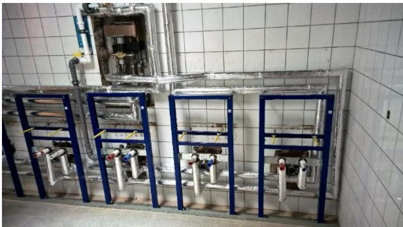
Abb. 41: Aufputzinstallation erneuerter Sanitärbereich
