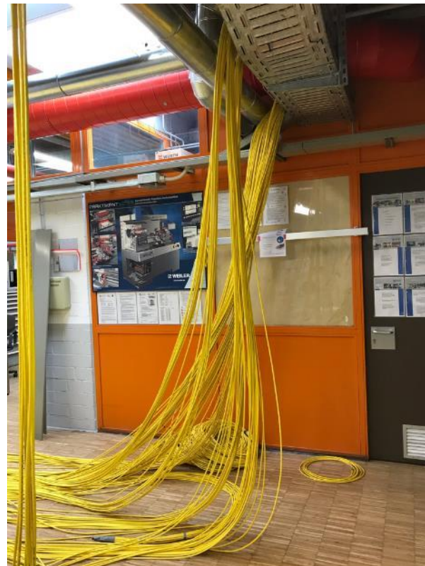
Abb. 39: Verlegung Datenkabel
