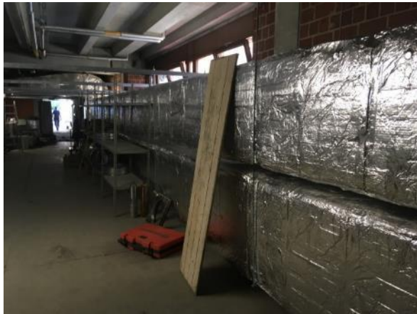
Abb. 18: Zu-/ Abluftkanäle
