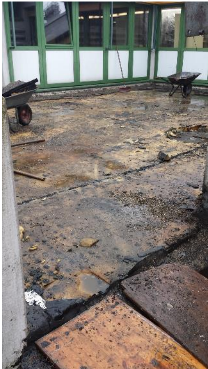
Abb. 44: Rückbau der Abdichtung
