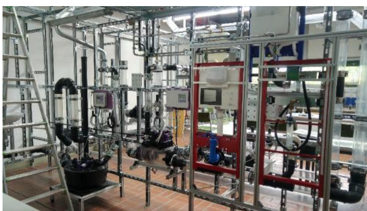
Abb. 30: Montage der Versorgungsleitungen Projektwand
