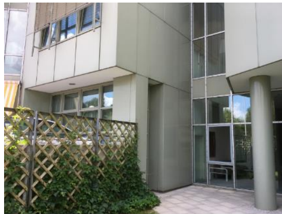
Abb. 10: Standort der Fluchttreppe
