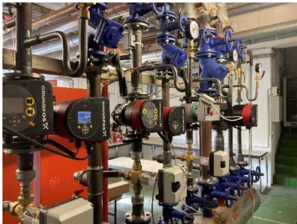
Abb. 63: Neue Heizungspumpen
