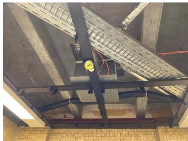
Abb. 64: Installation Brandmeldeanlage
