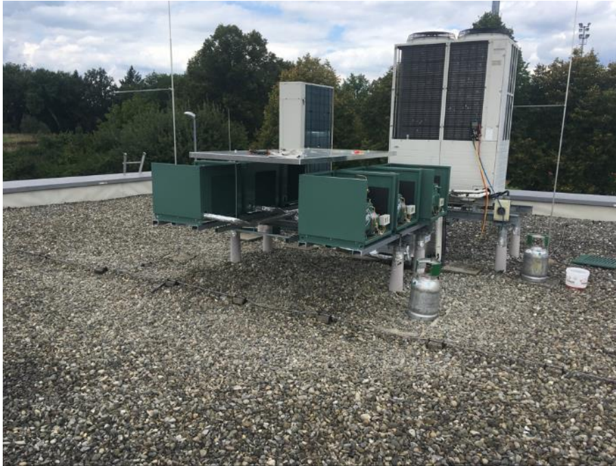
Abb. 33: Neuinstallation Kälteanlage auf dem Technikum Nahrung
