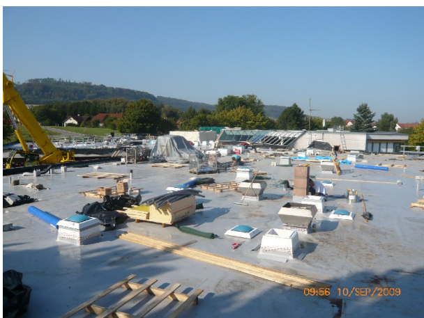
Einbau einer hochwertigen Wärmedämmung mit 8-11 cm Dicke zur energetischen Verbesserung des Gebäudes und Wärmeverbrauchsreduzierung.
