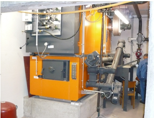
Bereits installierter Holzpelletkessel
