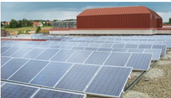
KBSZ Aalen: Hauptgebäude
