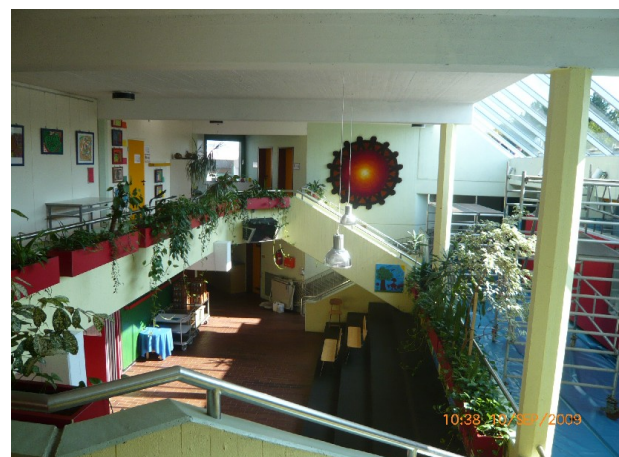
Durch das neue Glasoberlicht wird in der Schulaula weniger Beleuchtung benötigt und die Wärmedämmung verbessert. Die bisherigen glasfaserverstärkten Kunstharzplatten wurden durch die UV-Strahlung im Laufe der Jahre matt und lichtundurchlässig und führten durch Materialermüdung zu einem hohen Wärmeverlust.
