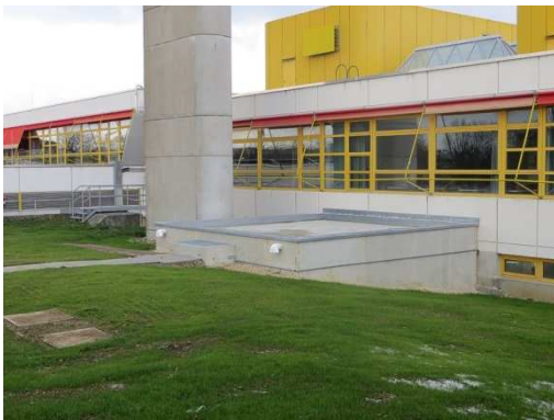
Pelletsilo (40 Tonnen Stauraum)
