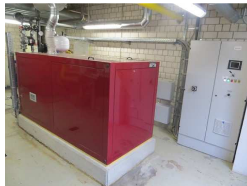
Erdgas-Blockheizkraftwerk
