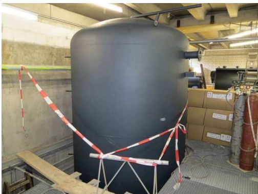
Pufferspeicher (20 m 3 Inhalt)
