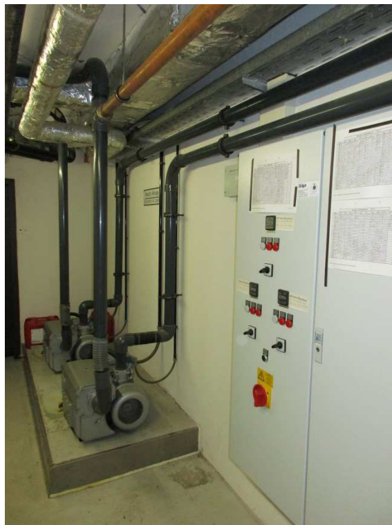
Bild 6 Vakuumanlage
