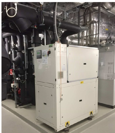
Kompressionskältemaschine
