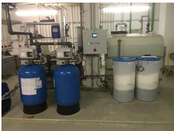
Neue Doppelfilterenthärtungsanlage
