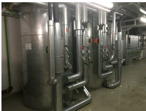
Konventioneller Warmwasserbereiter
