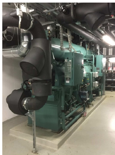
Absorptionskältemaschine
