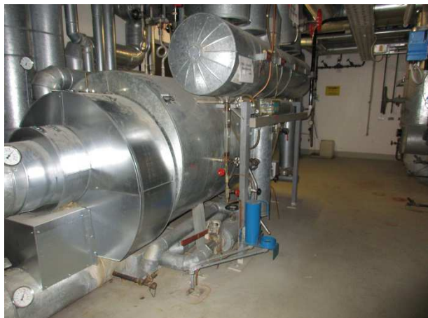
Bild 2 Reindampferzeuger Sterilisation Scheer & Cie.; Baujahr 1986; 1.503 l, 1.143 kW
