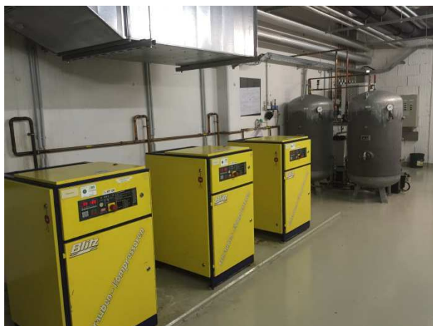
Kompressoranlage
