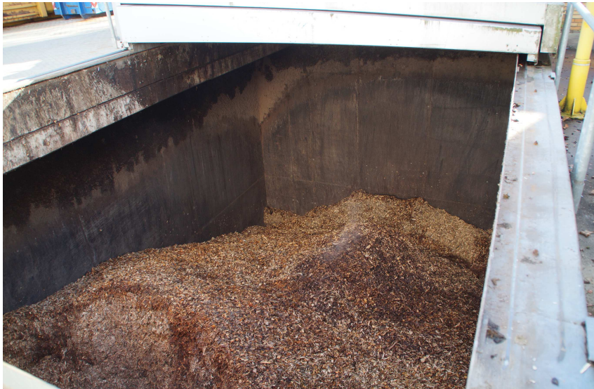
Abbildung 3: Hackschnittzelsilo
