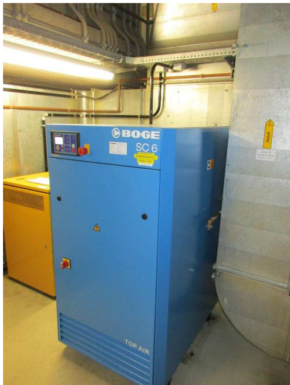
Bild 5 Kompressoren Medizinische Druckluft
