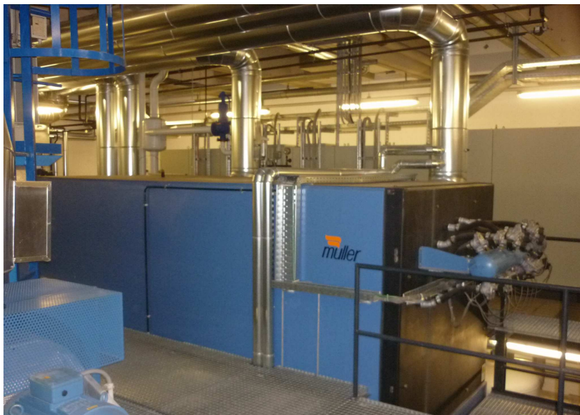
Abbildung 4: Hackschnitzel-Kesselanlage
