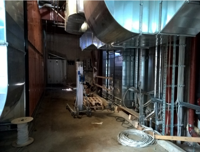
Einbau neue Lüftungszentrale
