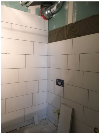
Fliesenarbeiten im WC-Kern
