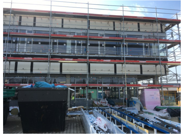
Montage Fensterelemente
