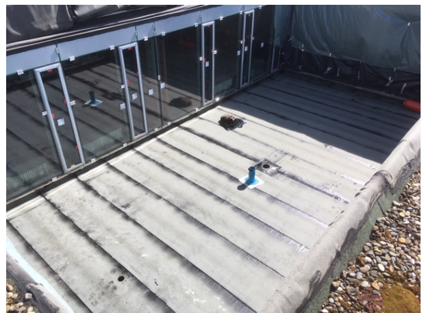
Erneuerung Abdichtung Innenhof
