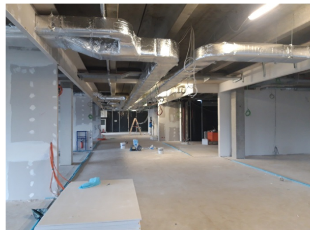
Montage Gipskartonwände und neue Lüftungskanäle
