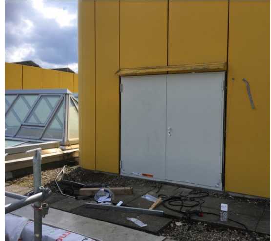
Neues Türelement Lüftungszentrale
