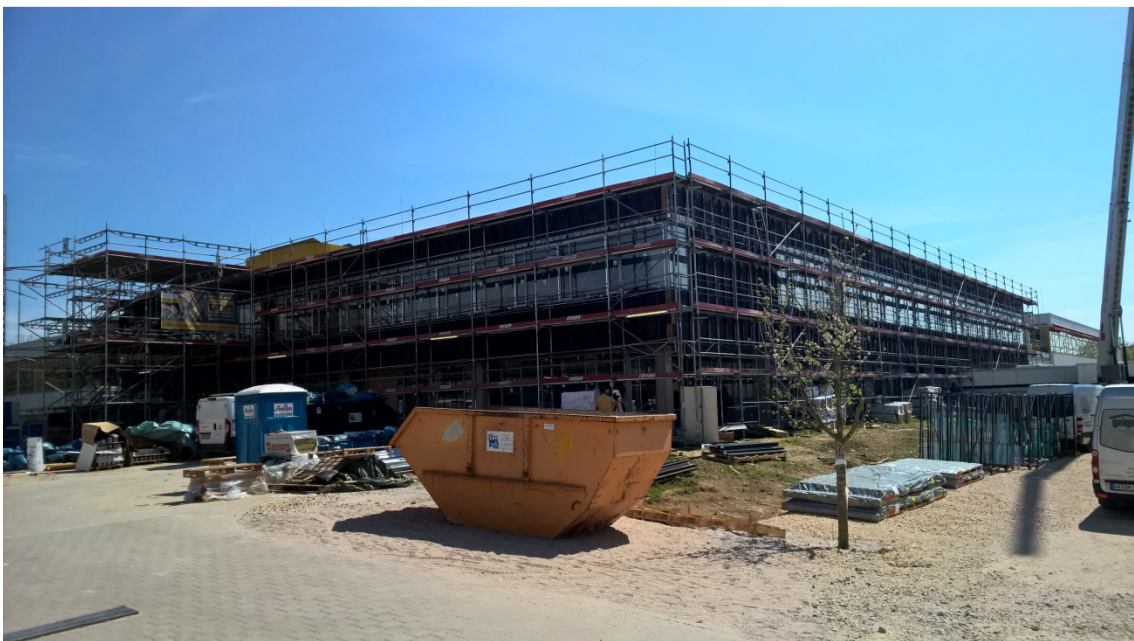
Montage Fensterelemente und Fassadendämmung
