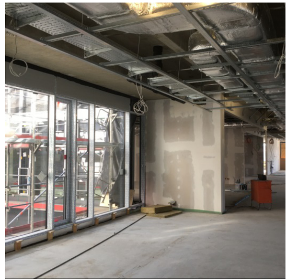
Unterkonstruktion für die Deckensegel
