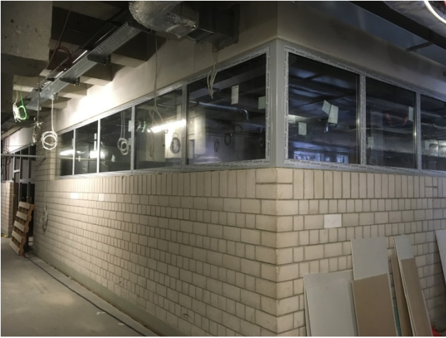
Einbau neuer Oberlichter
