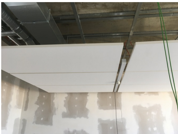
Montage Deckensegel und neue Beleuchtung
