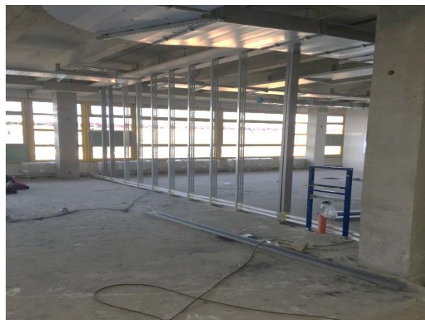
Vorbereitung Gipskartonwände
