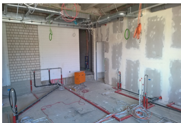
Rohinstallation Fachräume Chemie
