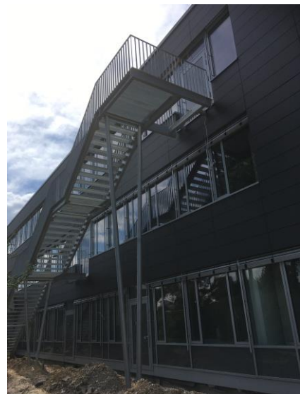
BA 4: neue Fluchttreppe Ostseite
