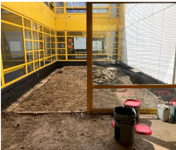
BA 4: vorbereitende Arbeiten Innenhof Fassade / Blitzschutz
