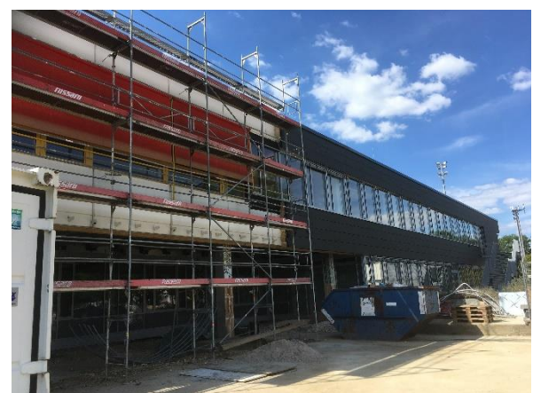
BA 3/BA 4: Beginn Schadstoffsanierung BA 4
