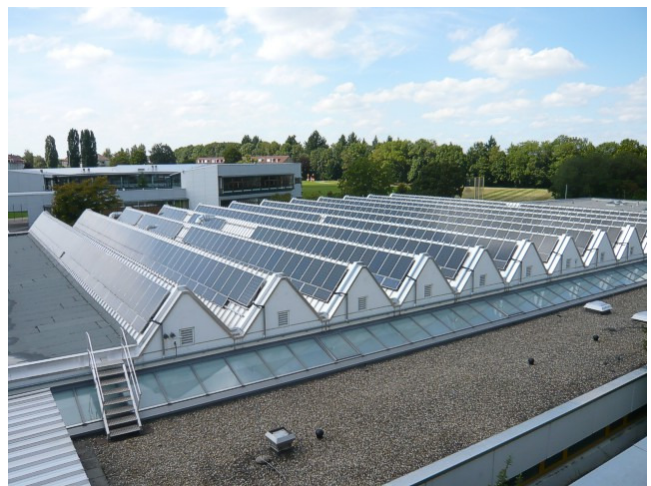
Nach der Sanierung sind die Werkstattdächer aus energetischer Sicht optimal aufgebaut.
