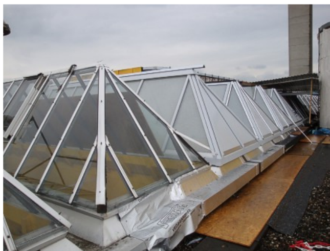
Schrittweise Erneuerung der Glaselemente.
