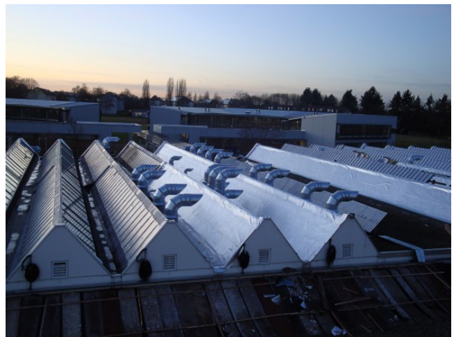
Die 24 Sheddächer wurden abschnittsweise saniert und der Schulbetrieb auf diese Weise nicht gestört.
