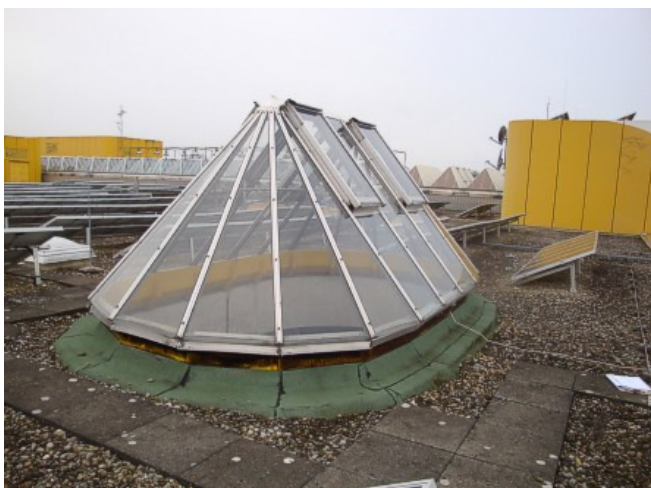
Vor der Sanierung: Eine der vier Glaspyramiden über den Nebentreppenhäusern.
