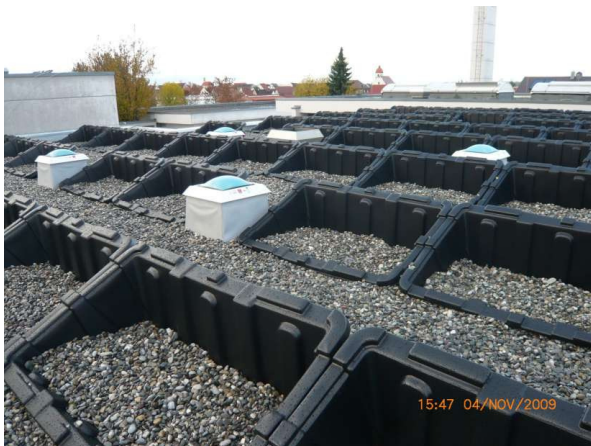
Installation, Ausrichtung und Befüllung der Modulwannen am 04.11.2009.
