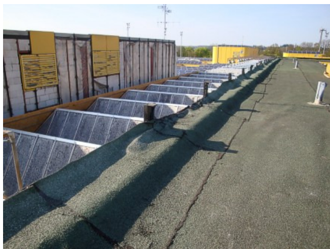
Zwischen den Technikzentralen befinden sich die 40 Oberlichtkonstruktionen, die erneuert werden.
