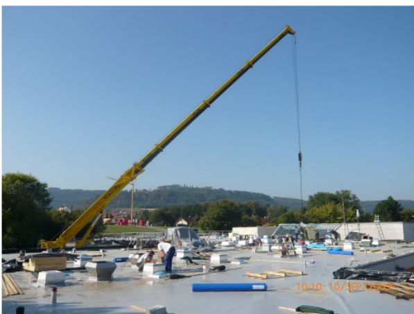
Die Dachsanierung ist in vollem Gange: Montage der neuen Oberlichtverglasung im Aulabereich.
