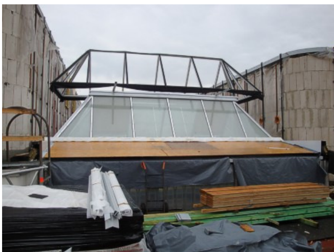
Austausch der Metallkonstruktion.
