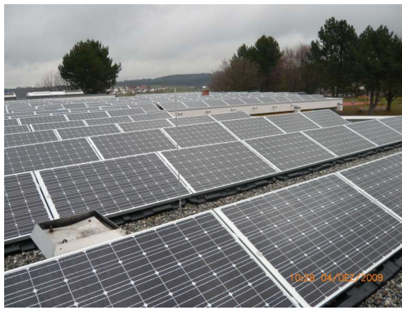
Ein Großteil der 558 Photovoltaikmodule des Hauptgebäudes sind am 04.12.2009 installiert.
