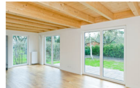
Holzbalkendecke und Massivbauwände
